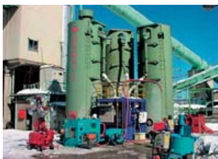
場外プラント設置状況
