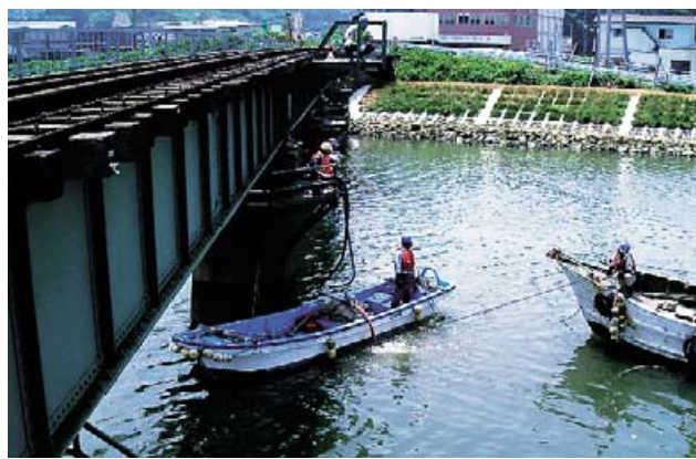
水中打設状況
