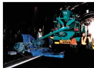
JETMS場内圧送例
