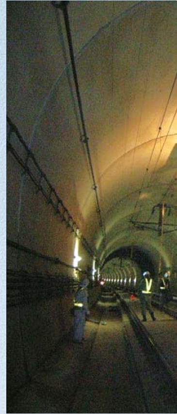
鉄道トンネル
