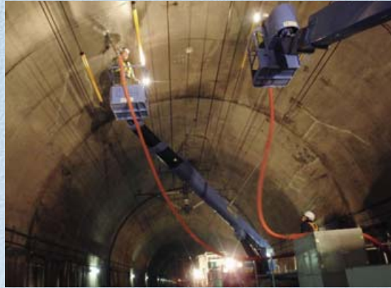
鉄道トンネル
